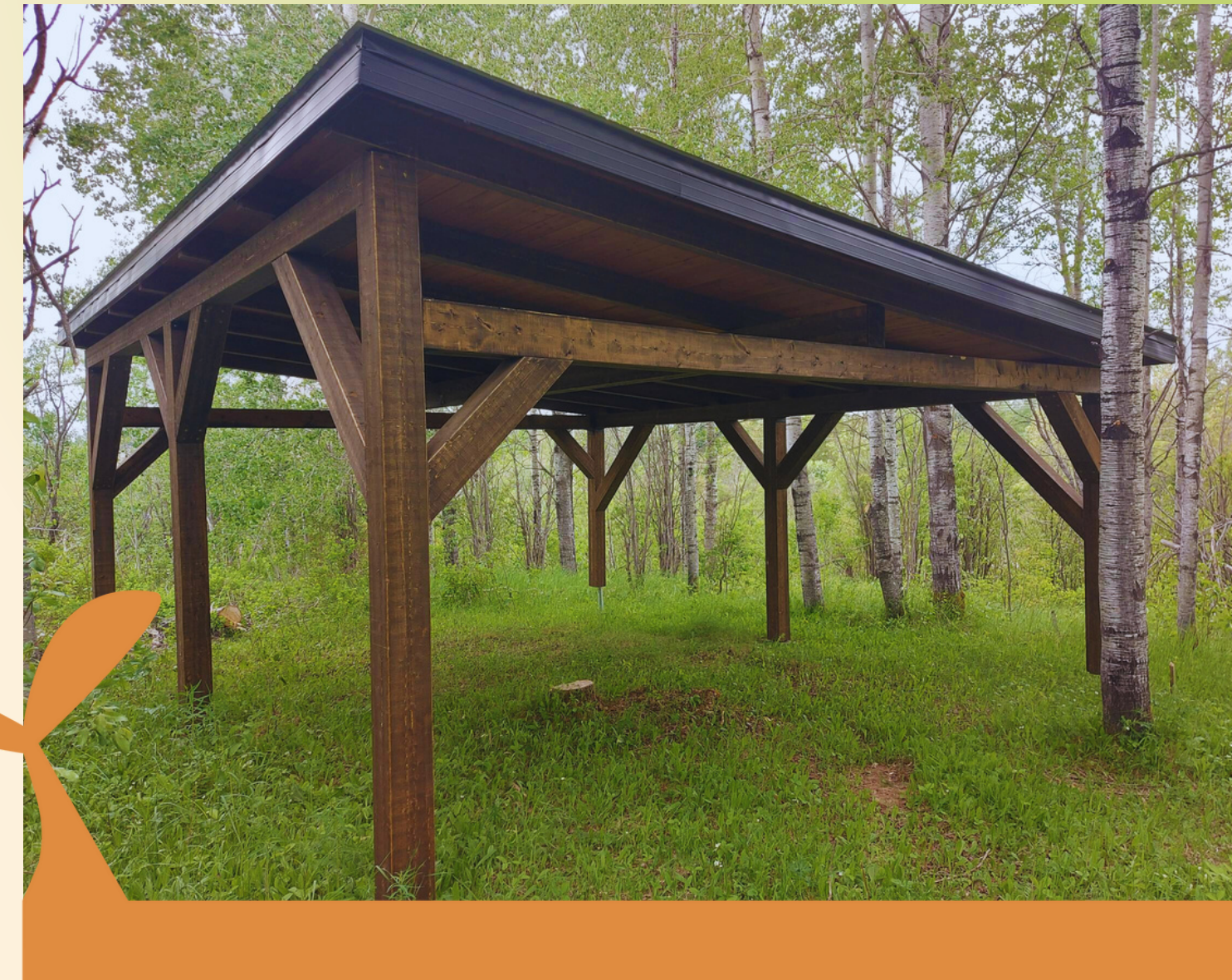
STRUCTURE EN BOIS
